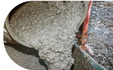
de la alta capacidad de reducción de agua, recomendamos un mezclado cuidadoso durante 5 minutos. Para evitar la exudación en el concreto y lograr la consistencia deseada, el agua restante de la mezcla recién se añadirá cuando hayan transcurrido 60 segundos del tiempo de mezclado. Cuando se trabaja con relaciones a/c bajas es recomendable mezclar el concreto de 7 a 10 minutos.
