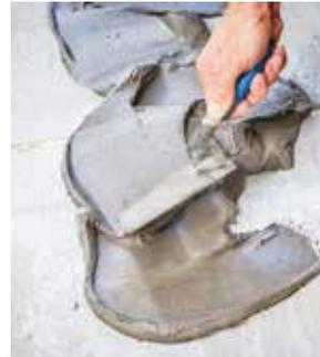
**1** Colocar el adhesivo en una llana dentada y se esparce con la parte plana, presionando para que se impregne en el muro o piso.
